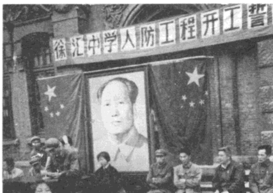
徐汇中学人防工程开工誓师大会(马学强提供)
